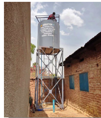
Pompe à énergie solaire et château d'eau
