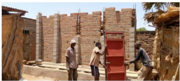
Construction de latrines : Ecole La Fidélité
