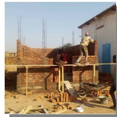
Extension du bâtiment de la maternité au centre de santé de Taye : construction de deux salles
