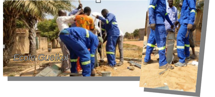
Travaux de changement de mécanisme et installation d'une pompe à main
